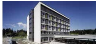
Fassade Hochhaus nach der Sanierung
